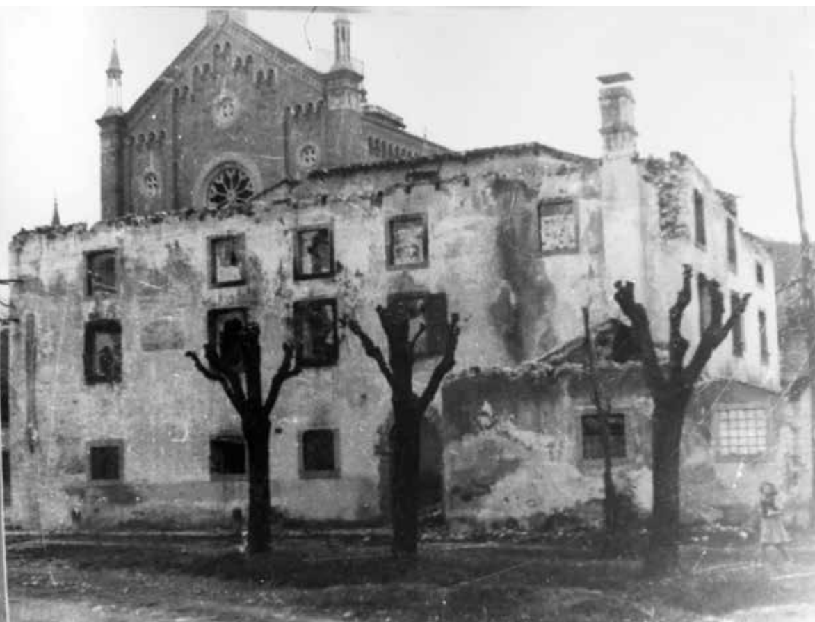
Faedis, 2.10.1944 La casa canonica dopo l'incendio dal paese
