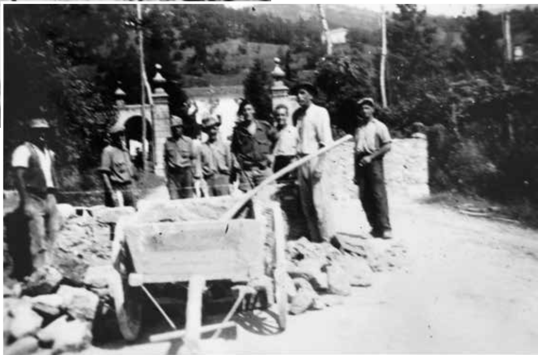
Faedis, settembre 1944 Costruzione di blocchi stradali
