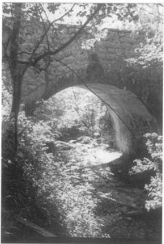
Il ponte sul Rio Barquet a Cesiaccio prima del bivio per la strada che porta ad Anduins. Oggi come sessant'anni fa: in alto il piano stradale e, sotto, la volta del manufatto.
